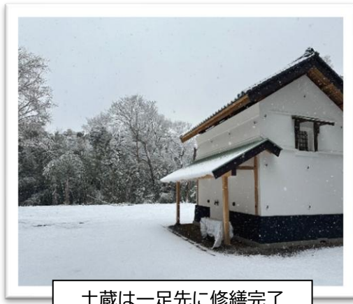
土蔵は一足先に修繕完了 2026年2月撮影
